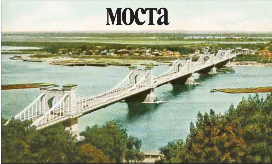
Николаевский цепной мост
